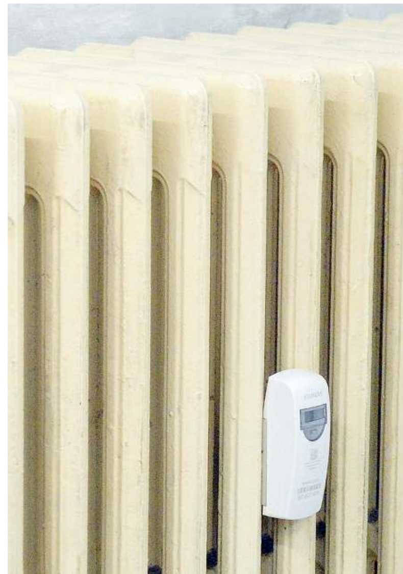
Installato. Un contabilizzatore applicato al calorifero // FOTO NEG
